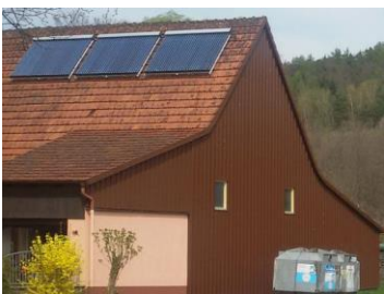
Bild: Die Kollektoren auf dem Dach lassen sich mit einem Heizungssystem im Keller kombinieren. © Ehlerding
